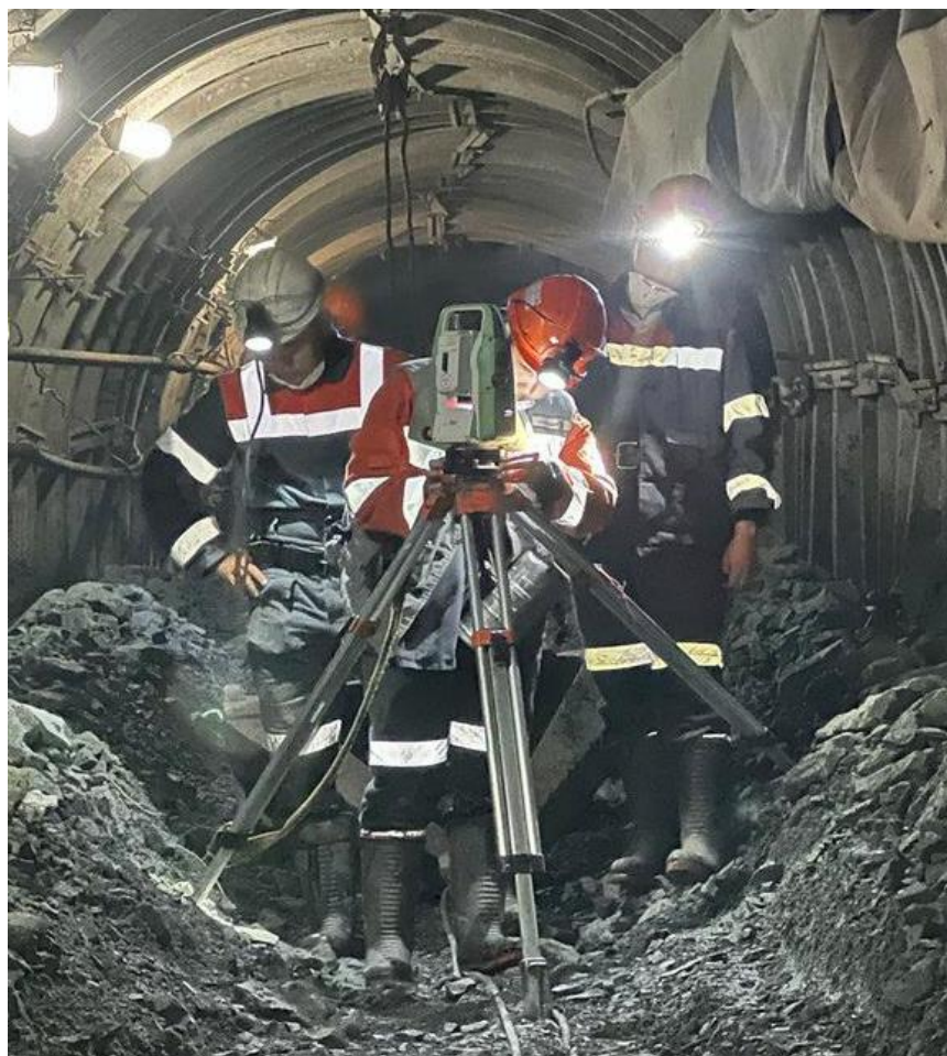
11.1-сурет – «Қазақстан Тәуелсіздігінің 10 жылдығы» шахтасында +80 горизонтында қазбаға көлденең жазықтықта бағыт беру жұмысы
